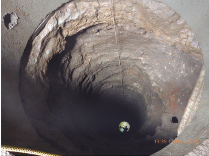
Figura 7. Aspecto actual del pozo D6 tras su excavación y acondicionamiento.
