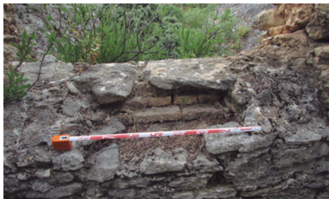
Fotos 8 y 9. Detalle de los tubuli empotrados en el acueducto. Photos 8 and 9. Detail of the tubuli embedded in the aqueduct.
