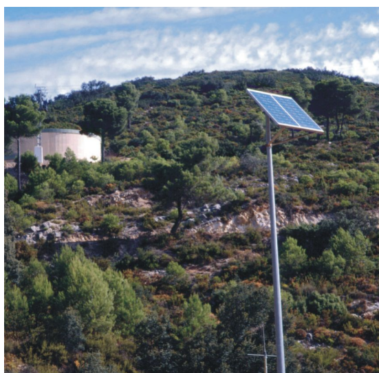
Figura 4. Antena de transmisión radio y alimentación fotovoltaica
