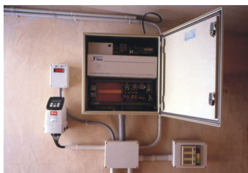
Figura 3. Composición de un equipo adquisición de datos e instalación junto con transductores
