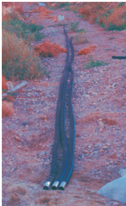
Foto 4. Instalación de sensores a diferentes profundidades en el sondeo de Bayana (Sierra de Gádor)
