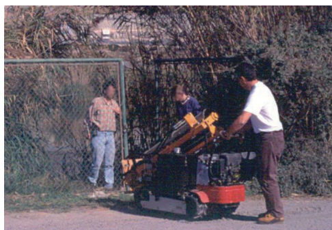
Foto 9. Realización de un piezómetro somero junto a la Reserva Natural de la Albufera Honda (Adra, Almería)
