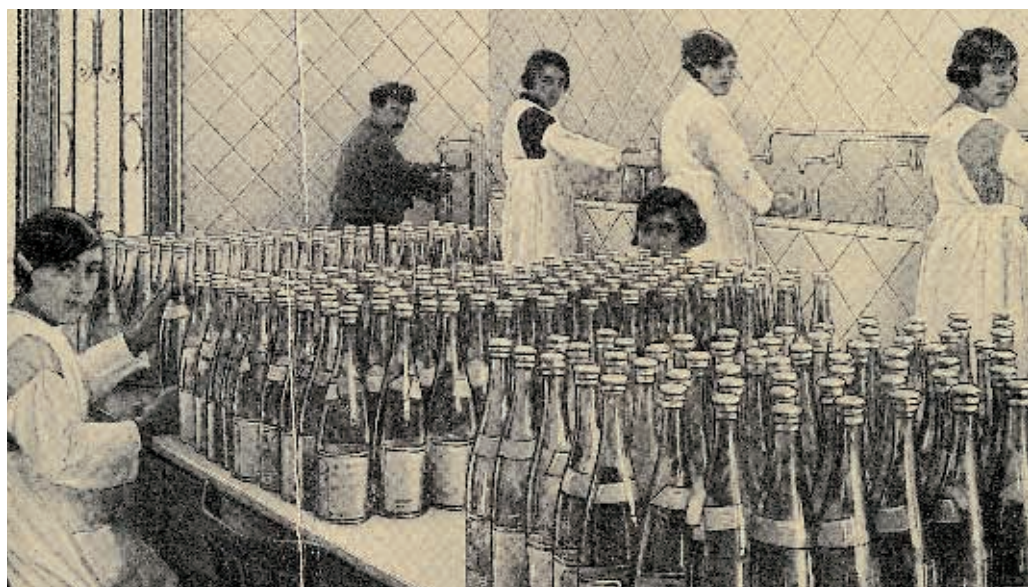
Antigua planta de envasado.
