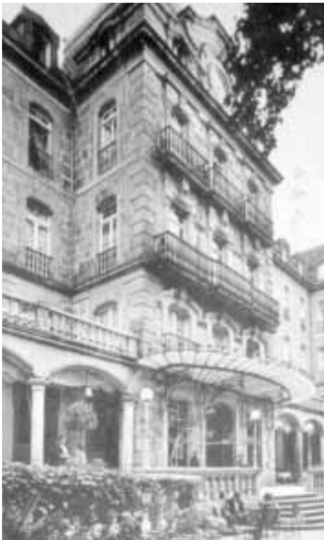
Fachada del antiguo edificio del Balneario de Mondariz (Pontevedra)
