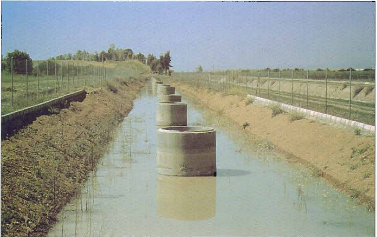
Fotografía 1 - Zanja de recarga artificial del aluvial del Guadalquivir (Sevilla).
