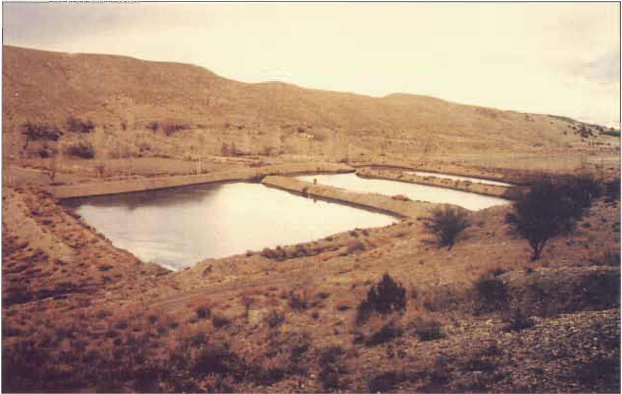
Fotografía 3 - Balsas de recarga artificial en el aluvial del río Verde Guadix (Granada).
