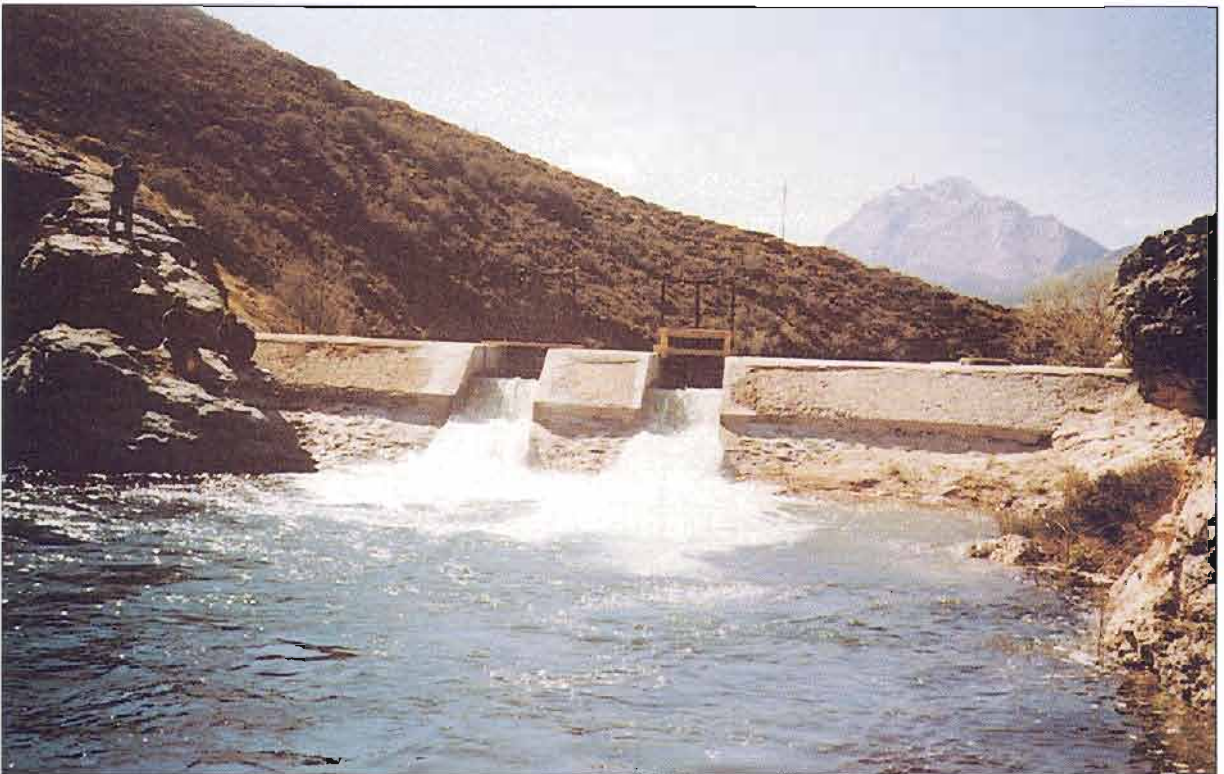
Fotografía 2 - Vertido de aguas del embalse de Camporredondo para infiltración en el arroyo Miranda.
