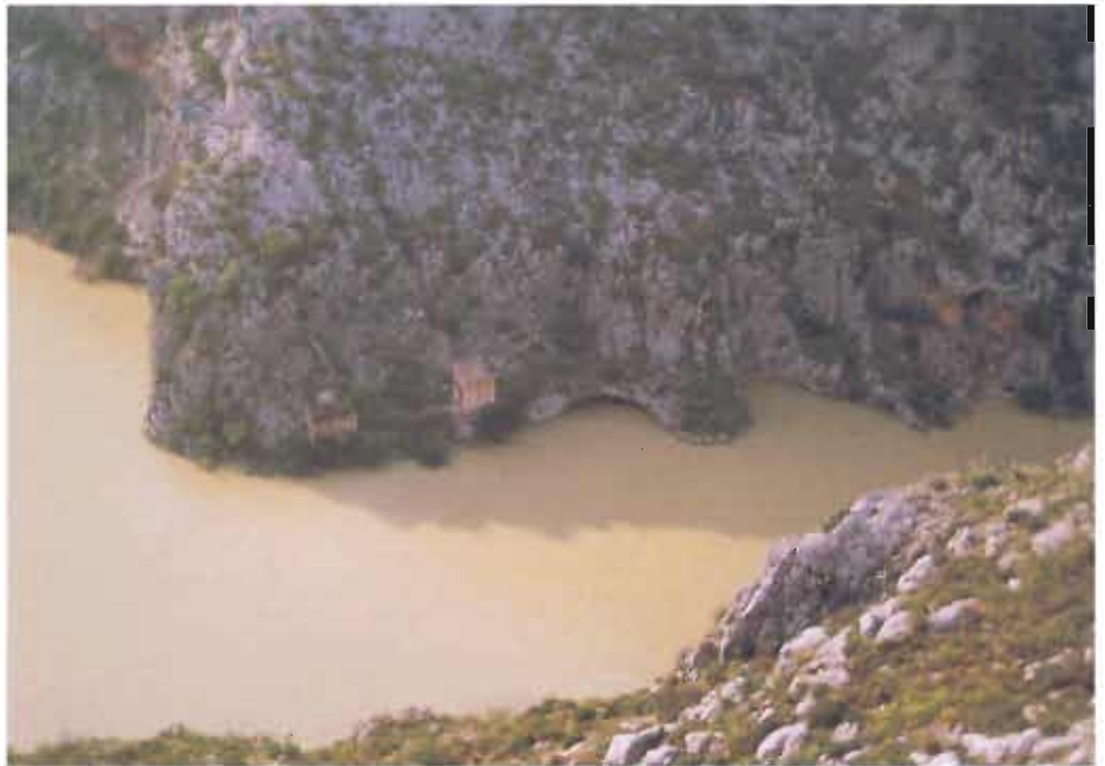
El embalse de Isbert presenta este aspecto en muy pocas ocasiones. Cuando así sucede, el agua retenida se infiltra rápidamente, dado el marcado carácter permeable de los materiales que constituyen su vaso, que presentan frecuentes oquedades y fracturas, tal y como se manifiesta en esta imagen, tomada en abril de 1997.
