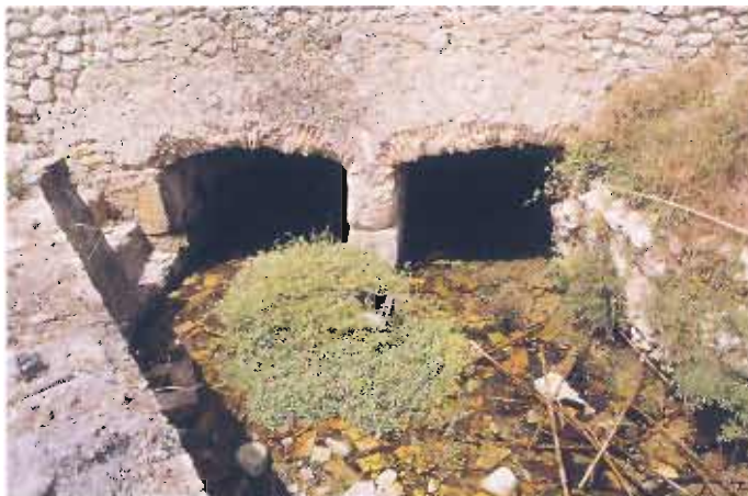
Las cavas son galerías horizontales de gran longitud que drenan el acuífero y transportan el agua hasta los centros de demanda. Algunas de estas cavas o galerías de drenaje vienen utilizándose desde tiempos inmemoriales.
