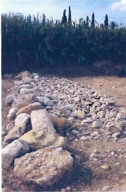
Zanjas filtrantes en el cauce del río Gorgos.
