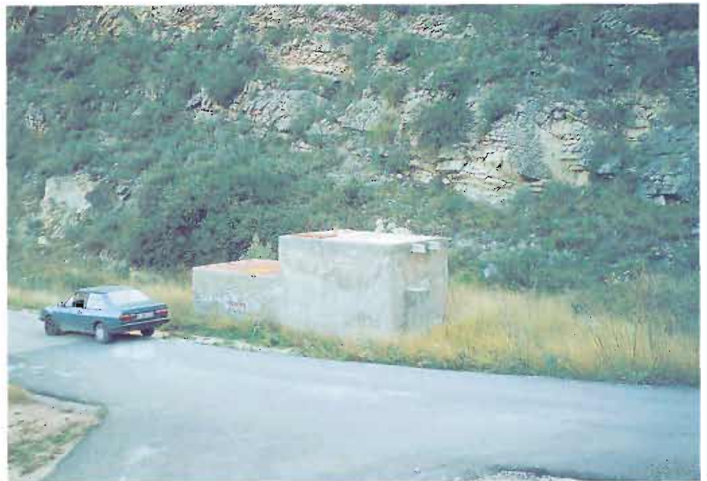
El pozo de recarga del acuífero de Jijona está situado a 200 metros de la captación para abastecimiento urbano. El sistema de recarga se encuentra totalmente automatizado y protegido por una caseta.
