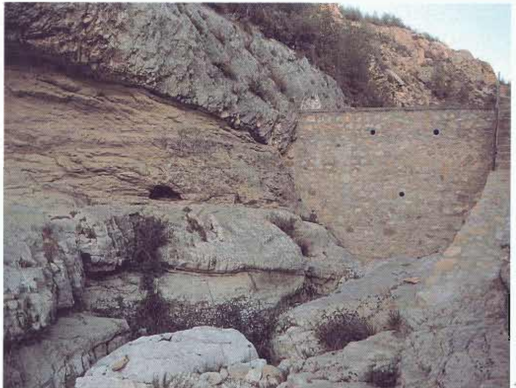
Presa de vaso permeable construida en la cabecera del río Coscón.
