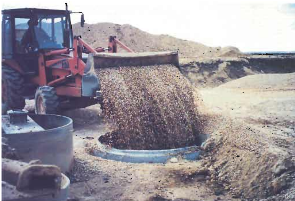
Los pozos colgados son dispositivos de recarga artificial en fase experimental cuyo interior se rellena en ocasiones con grava para reducir el efecto de la colmatación.
