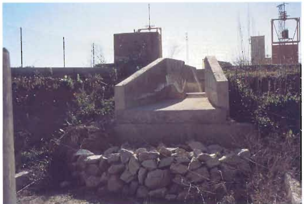
A la entrada y a la salida de las instalaciones de recarga artificial es conveniente instalar dispositivos de control de caudal para cuantificar el volumen de agua realmente introducido en el acuífero.
