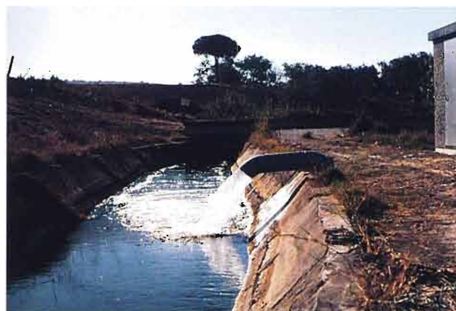
Detalle del Sondeo Arcos III bombeando un caudal de 100 l/s durante la última sequía (verano de 1995). Plan de Emergencia abastecimiento a la Bahía de Cádiz. (70)
