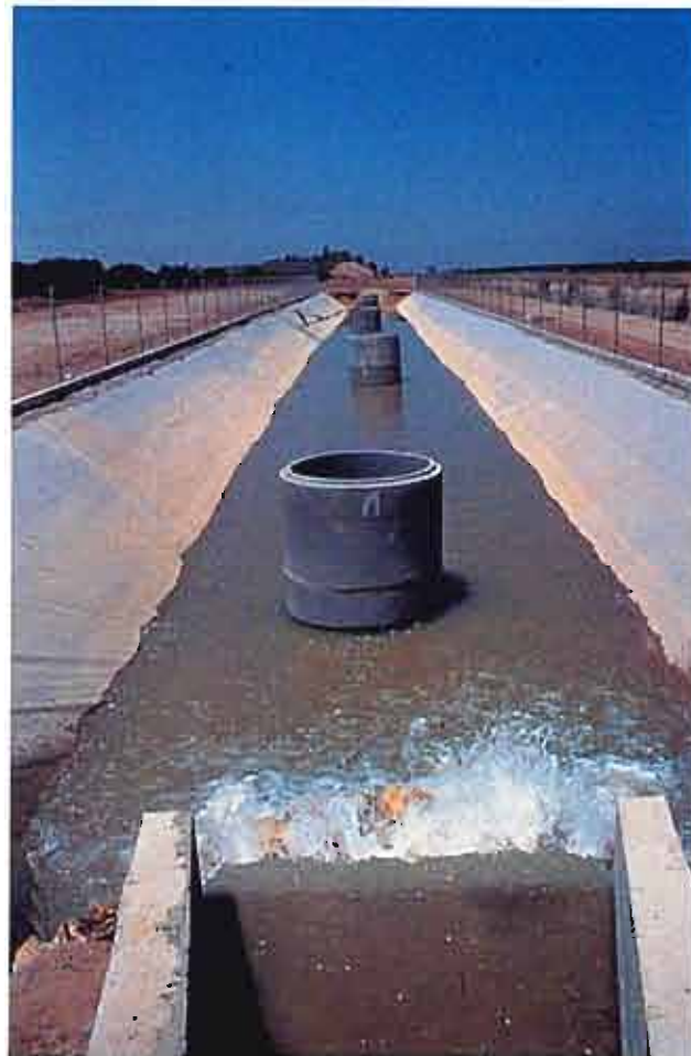
Experiencia de recarga artificial con el sistema mixto de zanjas y pozos totalmente penetrantes en el acuífero. (52)
