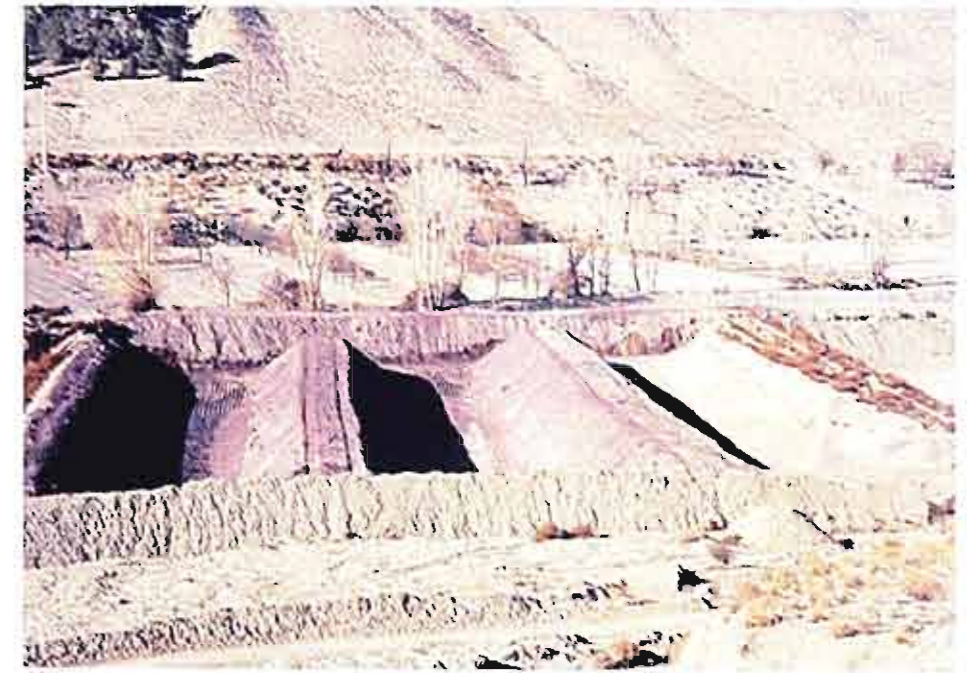
Construcción de balsas para recarga artificial en el acuífero de Guadix. (46)
