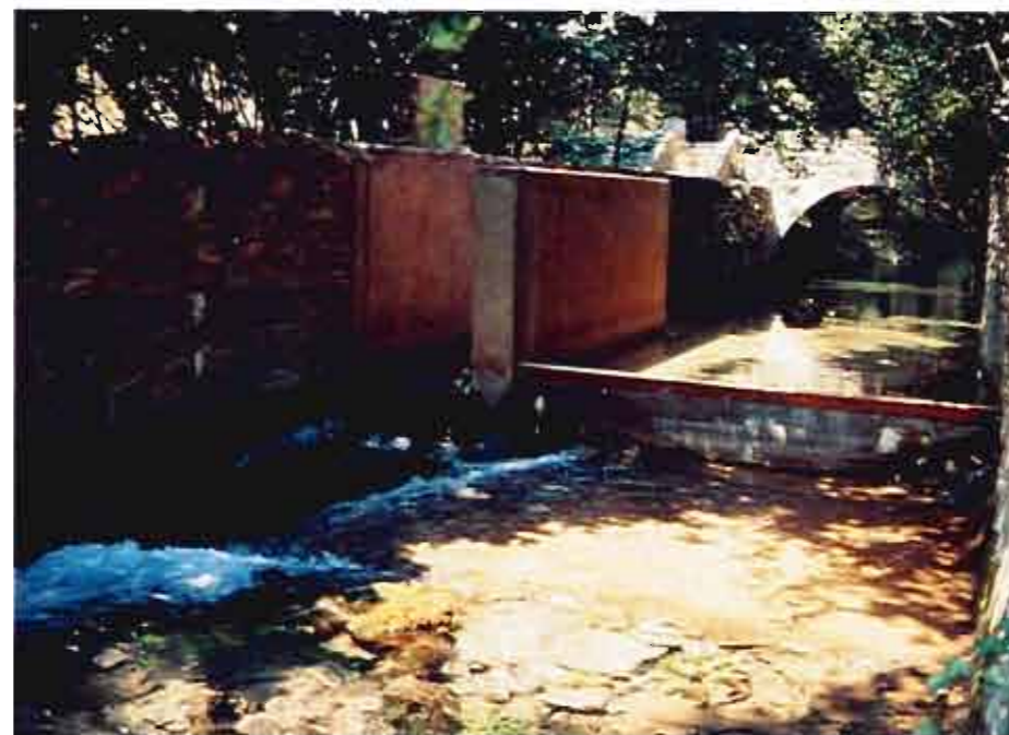
Estación de aforo en el Mancelal de la Natividad (Macizo del Río Guardal) (37)
