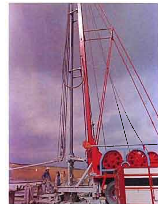
Perforación de un sondeo geotérmico en la Vega de Granada. (26)
