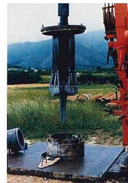
Trépano, útil de perforación con guía del Método de Percusión y boca del sondeo. (13)
