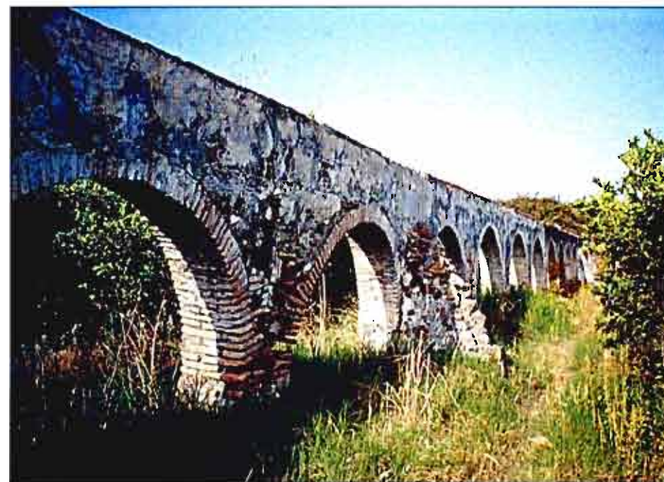
Acueducto Romano de Estepona (103)
