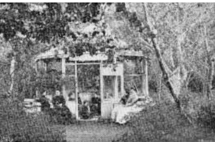
Zona de cura hidropínica en el Balneario de La Aliseda (Jaén)
